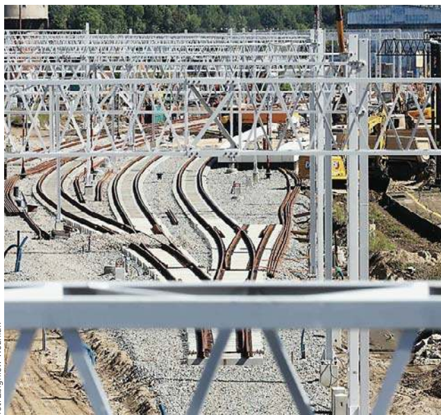
Na dworcu trwa również przebudowa torów
