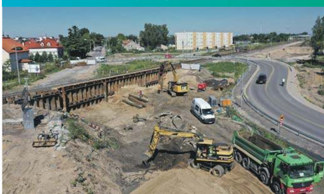
Budowa wiaduktu kolejowego nad ul. Kolejową
