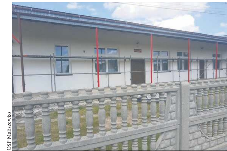
Właśnie trwa długo wyczekiwany remont strażnicy
