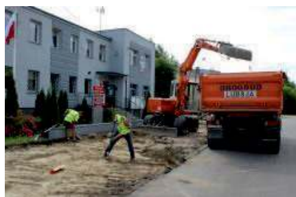
Budowa parkingu i chodnika ul. Krótka Dofinansowanie z Funduszu Dróg Samorządowych
