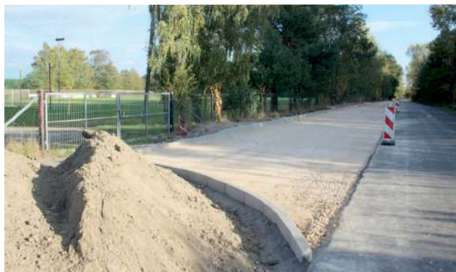
Budowa parkingu i remont drogi przy stadionie sportowym Rządowego Funduszu Polski Ład
