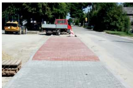
Budowa chodnika ul. Wojska Polskiego dofinansowano z Państwowego Funduszu Celowego w ramach Rządowego Funduszu Rozwoju Dróg
