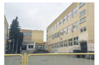
SP nr 8 zachowała szansę na szybka termomodernizację miasto miało 13,9 mln zł; najniższa cena na docieplenie SP nr 7, II LO i PM nr 12 wyniosła 20,9 mln zł, a miasto przewidziało 13,4 mln zł.
