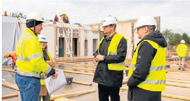
Trwa montaż „modułowego” żłobka
