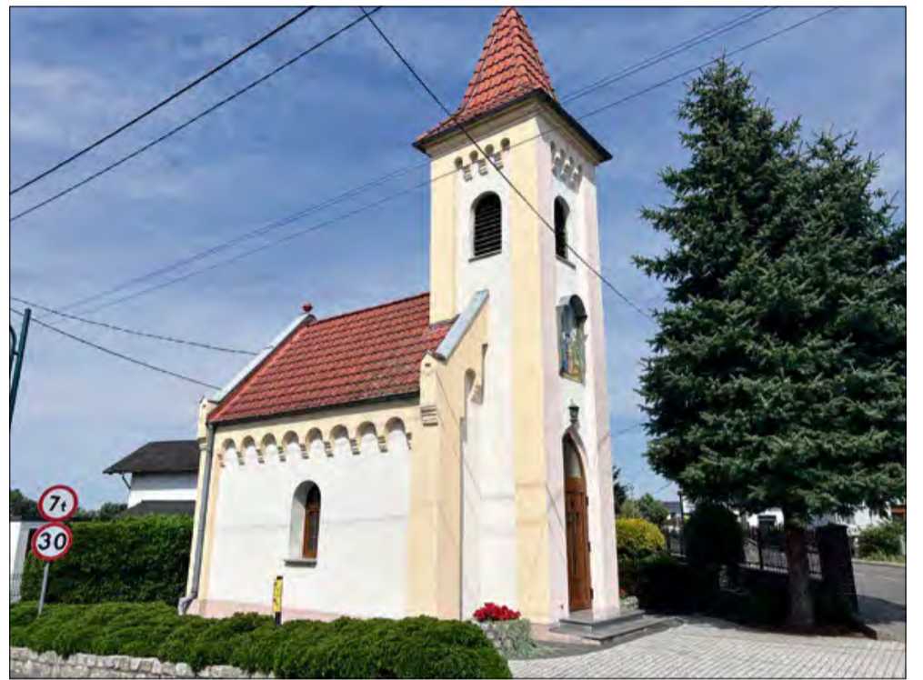
Wysunięta ku ulicy wieża-dzwonnica harmonijnie łączy się z korpusem głównym zwieńczonym sklepieniem łukowym, a całość pokrywa stromy, dachówkowy dach.
