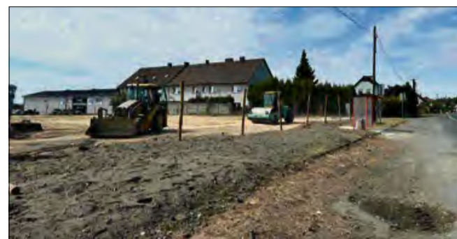
Na razie trwa przygotowanie placu budowy.
