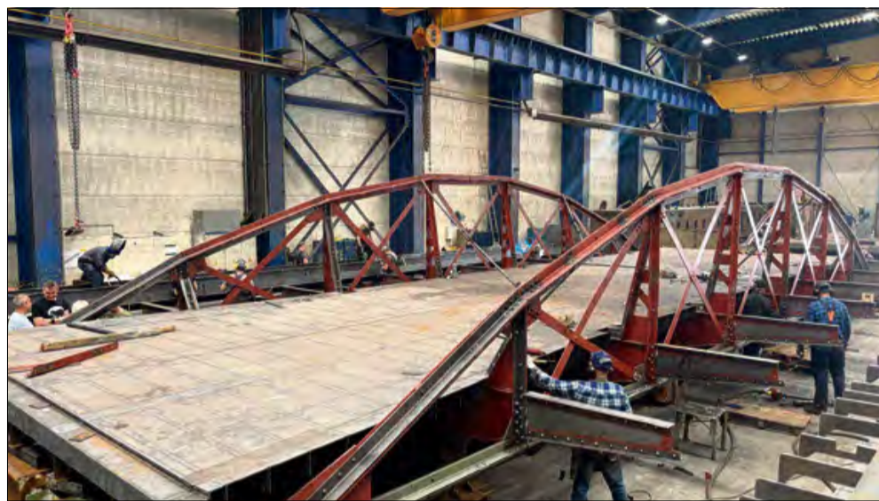
Odnowiona konstrukcja niebawem wróci do Opola. Po zakończeniu prac remontowych most finalnie będzie żółto-zielony.
