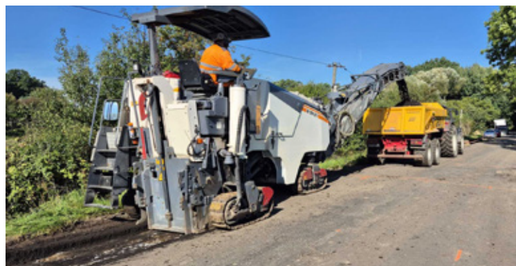
Remont drogi powiatowej nr 1290D na odcinku Piotroniowice - Łososiowice.
