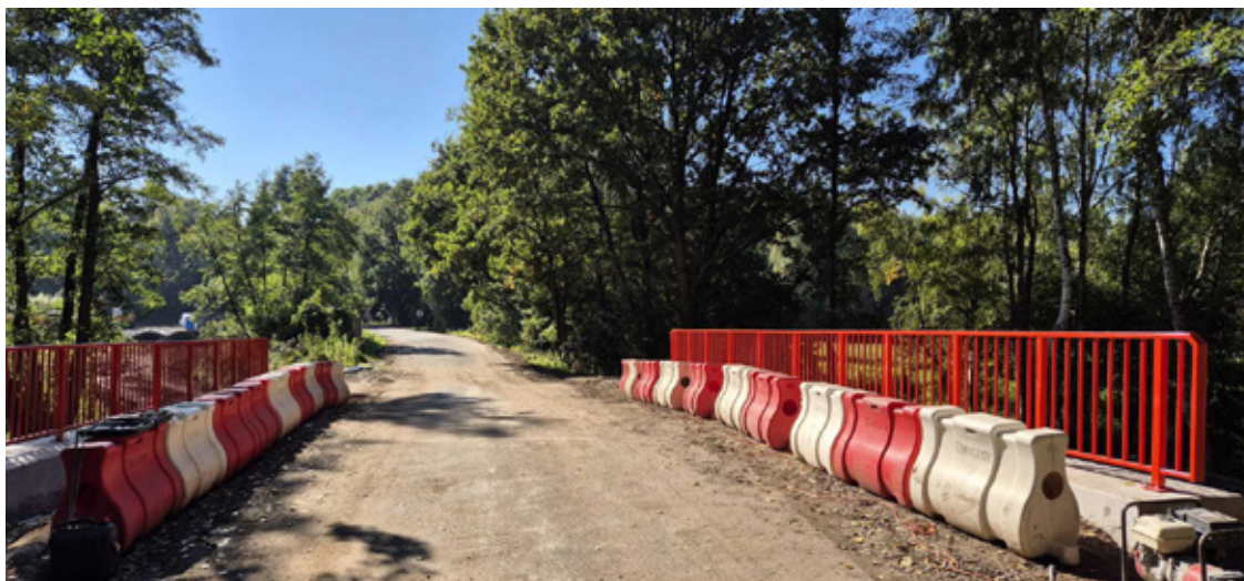
Remont Mostu w ciągu drogi pow. nr 1290D, Łososiwice- Piotroniowice. Wartość zadania wynosi 643 191,60 zł. Finansowanie w 100 proc. ze środków zewnętrznych.
