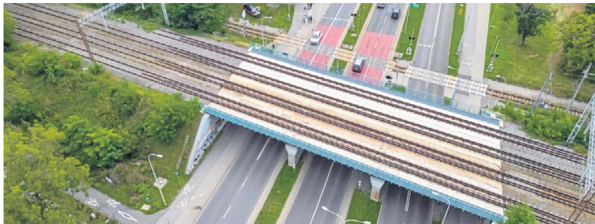
Znikną tory widoczne na zdjęciu powyżej wiaduktu
