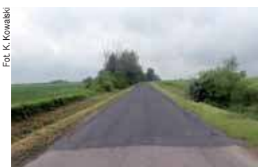
Nowo położona nakładka asfaltowa zakryła największe dziury
