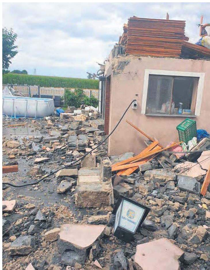
Zniszczenia na posesji na ul. Dworcowej w Cekcynie. Fot. nadesłane
