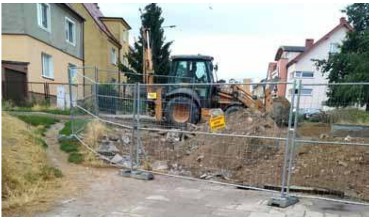
Mieszkańcy Osiedla Zachód muszą uzbroić się w cierpliwość, prace budowlane przy SP nr 2 potrwać do końca października
