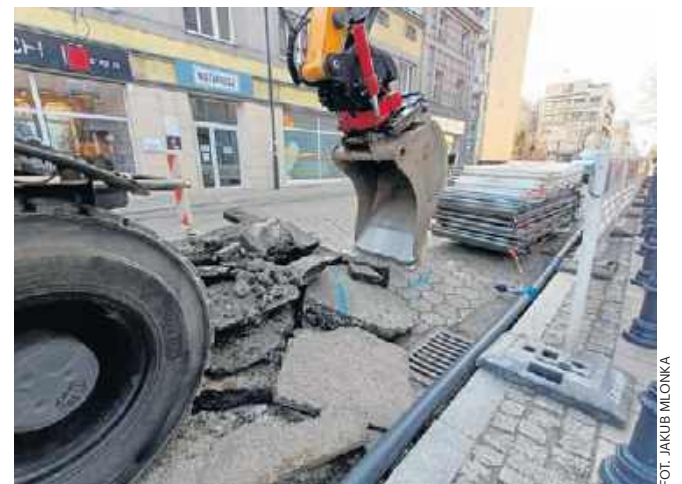
Pierwsze prace na Wigury to montaż tymczasowego wodociągu
