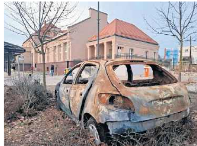
Wrak samochodu, który przez ponad rok straszyl przy wyremontowanym za 25 mln zł dworcu Toruń Miasto. Zobowiązany był go usunąć zarządca terenu, czyli spółka PKP SA
