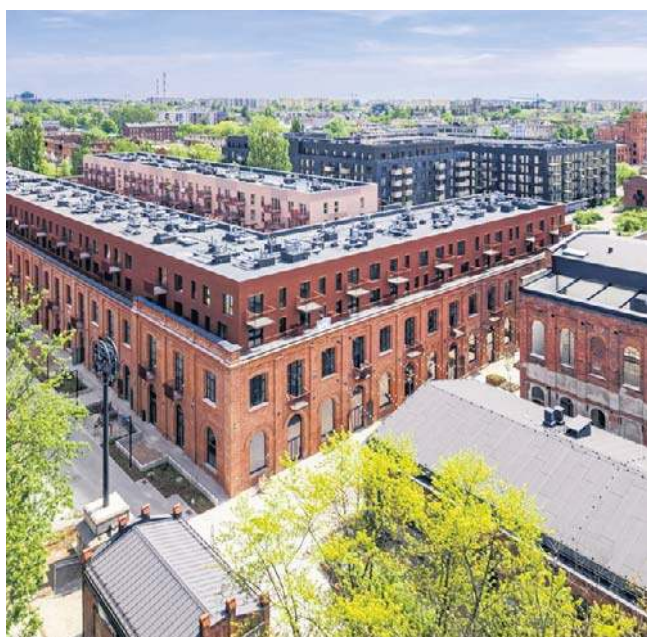
Wieloetapowa i prestiżowa inwestycja Fuzja w części mieszkalnej oferuje lokale w nowym budynku i odrestaurowanych loftach
