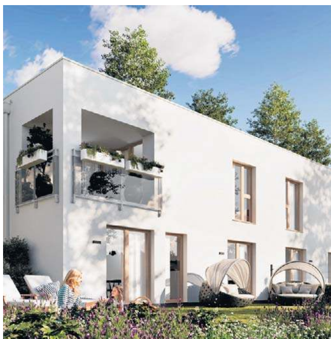
64 mieszkania (od trzy- do pięciopokojowych) w 17 budynkach – Przystań Młynek przy ul. Kotoniarńskiej, przy Parku na Młynku
