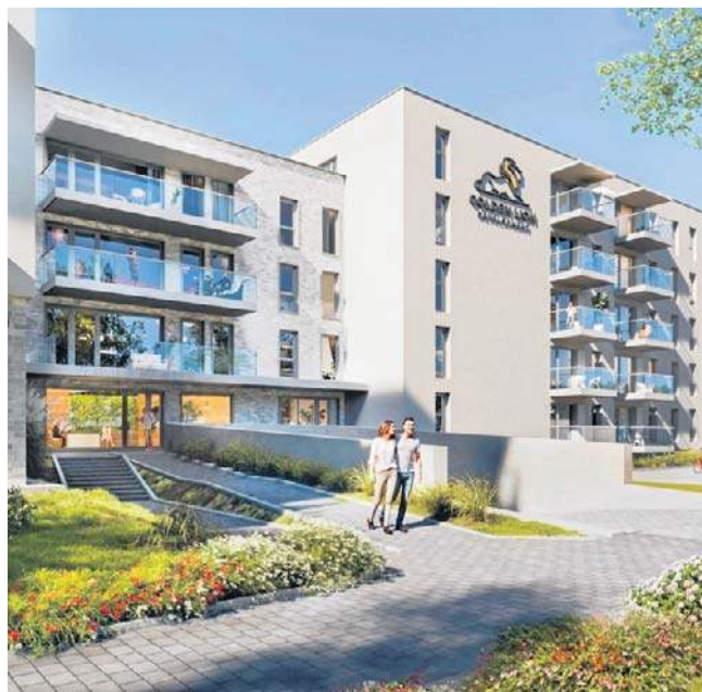
W ramach inwestycji Enklawa Natury powstały już trzy budynki – zaprojektowano w nich 173 mieszkania o pow. 42-108 mkw.
