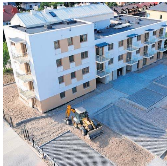
Nowy Konstantynów – kameralny trzypiętrowy budynek, w którym zaprojektowano 25 mieszkań o pow. 39-70 mkw.
