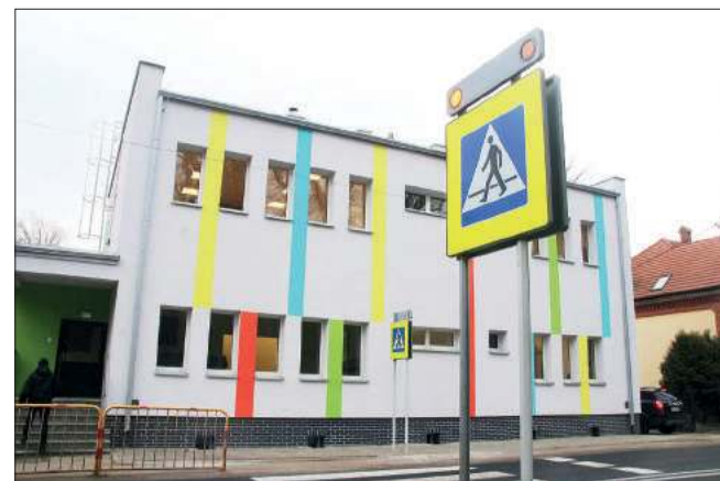
■ Po kontroli strażaków w przedszkolu w Rudach stwierdzono nieprawidłowości w zabezpieczeniach przeciwpożarowych, lecz mimo tego zajęcia w placówce mogą odbywać się normalnie
