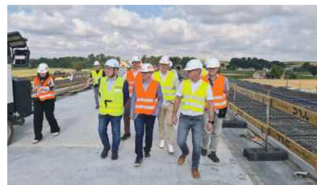
■ Na budowie nowego mostu spotkali się przedstawiciele samorządu województwa, lokalnych samorządów, wykonawcy oraz Zarządu Dróg Wojewódzkich w Katowicach. FOT. DAWID MACHECKI
