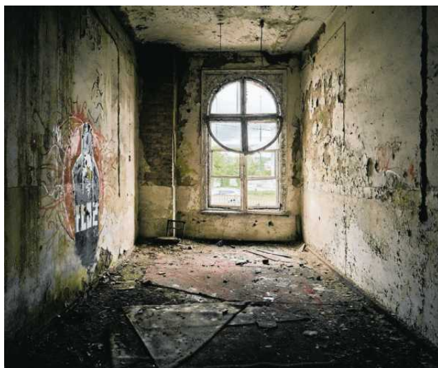
• Po transformacji ustrojowej imperium zaczęło się sypać FOT. MARCIN STĘPIEŃ / AGENCJA WYBORCZA.PL
