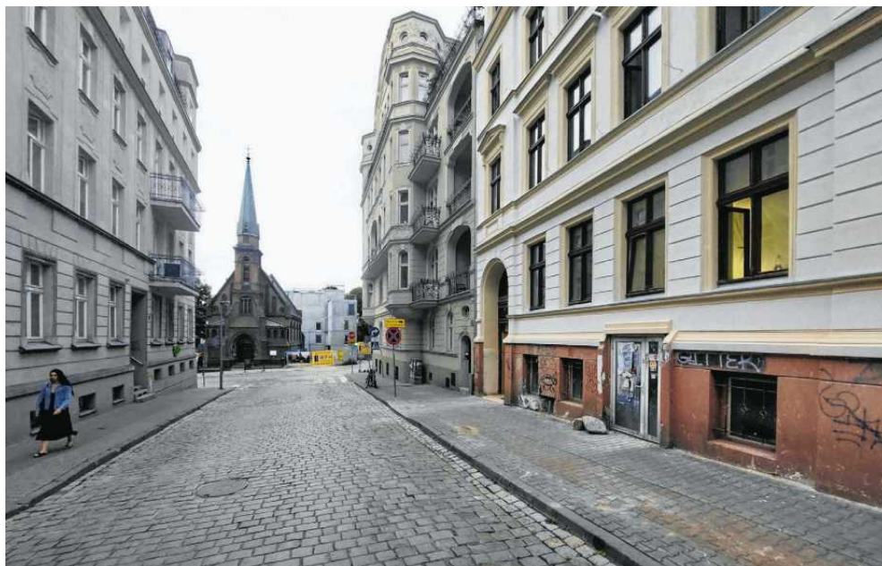
• Zdaniem PINB remont kamienicy przy ul. Piekary 13B to klasyczny przykład samowoli budowlanej FOT. PIOTR SKÓRNICKI / AGENCJA WYBORCZA.PL
