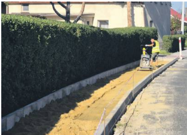
Trwa budowa chodnika w Gołostowicach
