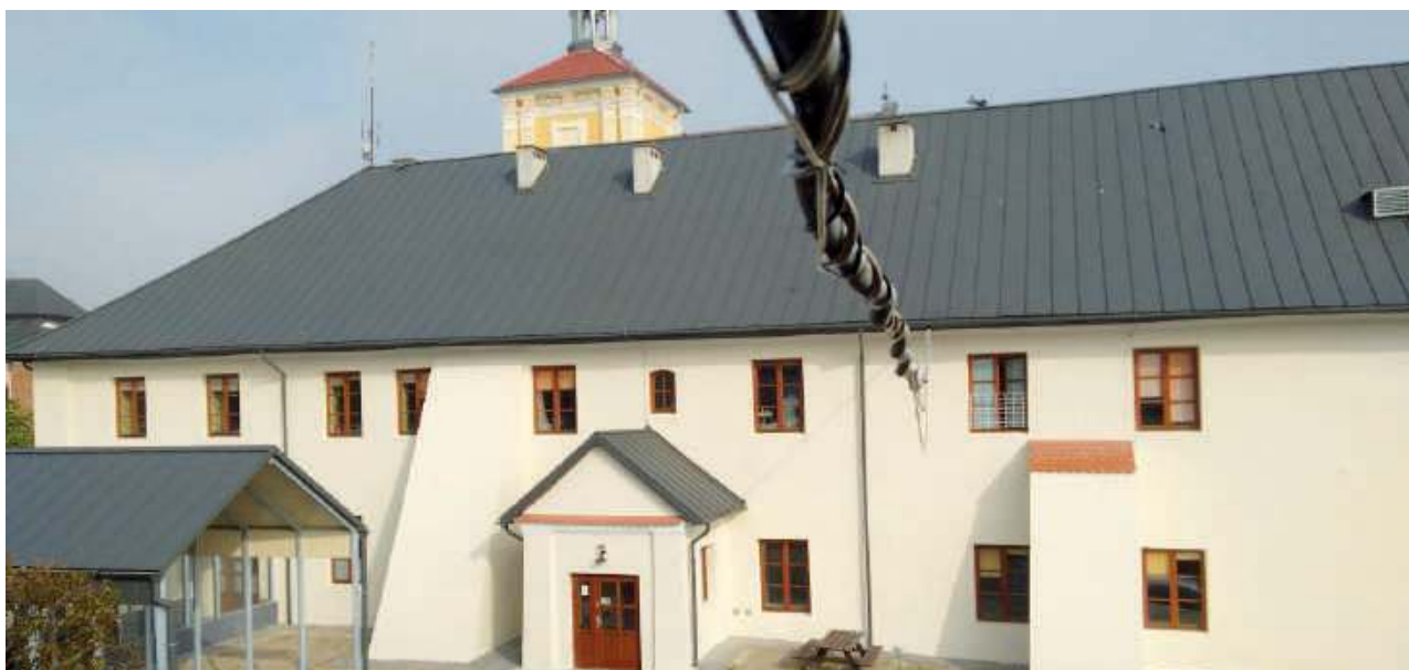
Budynek Szpitala w Szczepieszynie po remoncie elewacji.
