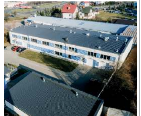
Budynek dydaktyczny ul. Szczepieńskiego 31
