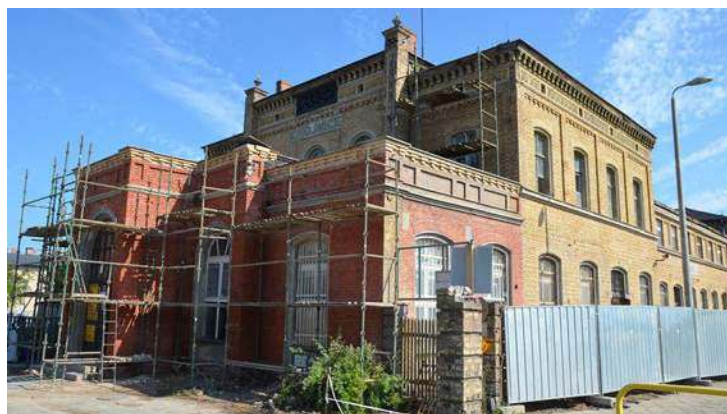
Dwa kolory elewacji są widoczne już na obecnym etapie prac.
