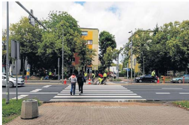
Prace przy budowie sygnalizacji ruszyły wczoraj
