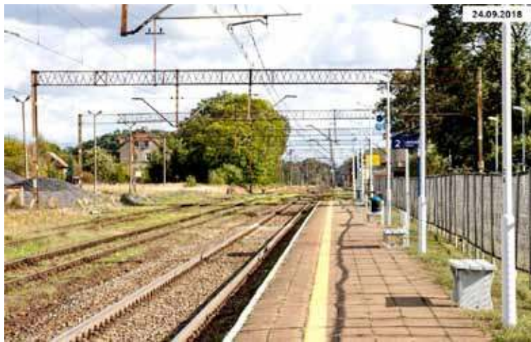
Stacja Dolice przed modernizacją fot. PKP PLK
