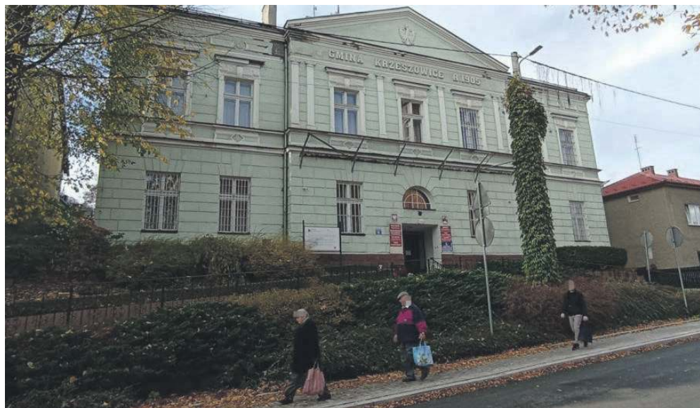
Budynek urzędu miejskiego przy ul. Grunwaldzkiej 4 w Krzeszowicach przejdzie duży remont
