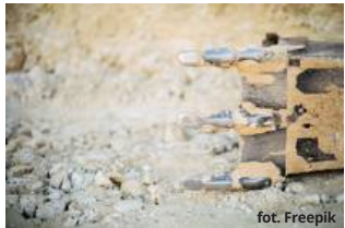
Budowa żłobka dobiega powoli końca. Gmina chce teraz zadbać o szczegóły
