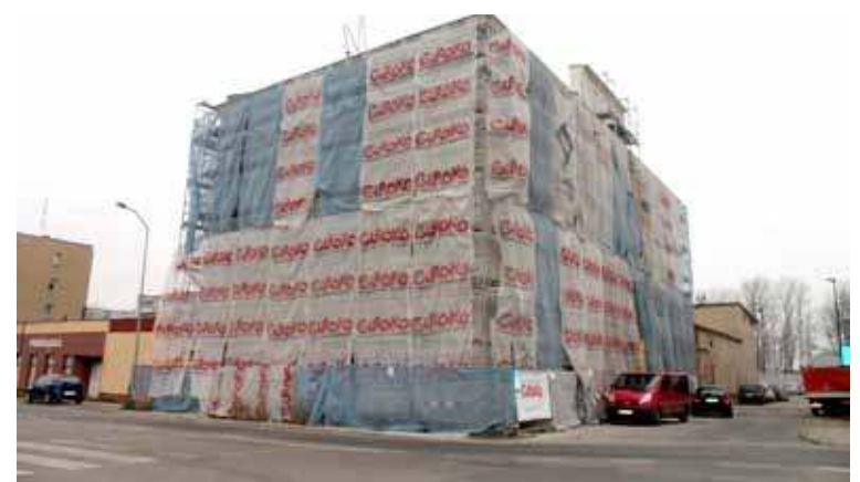
Kontynuowane będą inwestycje związane z budową Stargardzkiego Centrum Nauki przy ul. Chrobrego
