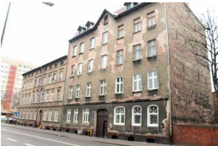
Będzie modernizacja energetyczna wielorodzinnych budynków mieszkaniowych przy ul. M. Konopnickiej 2,3 i M. Konopnickiej 10 a,b.
