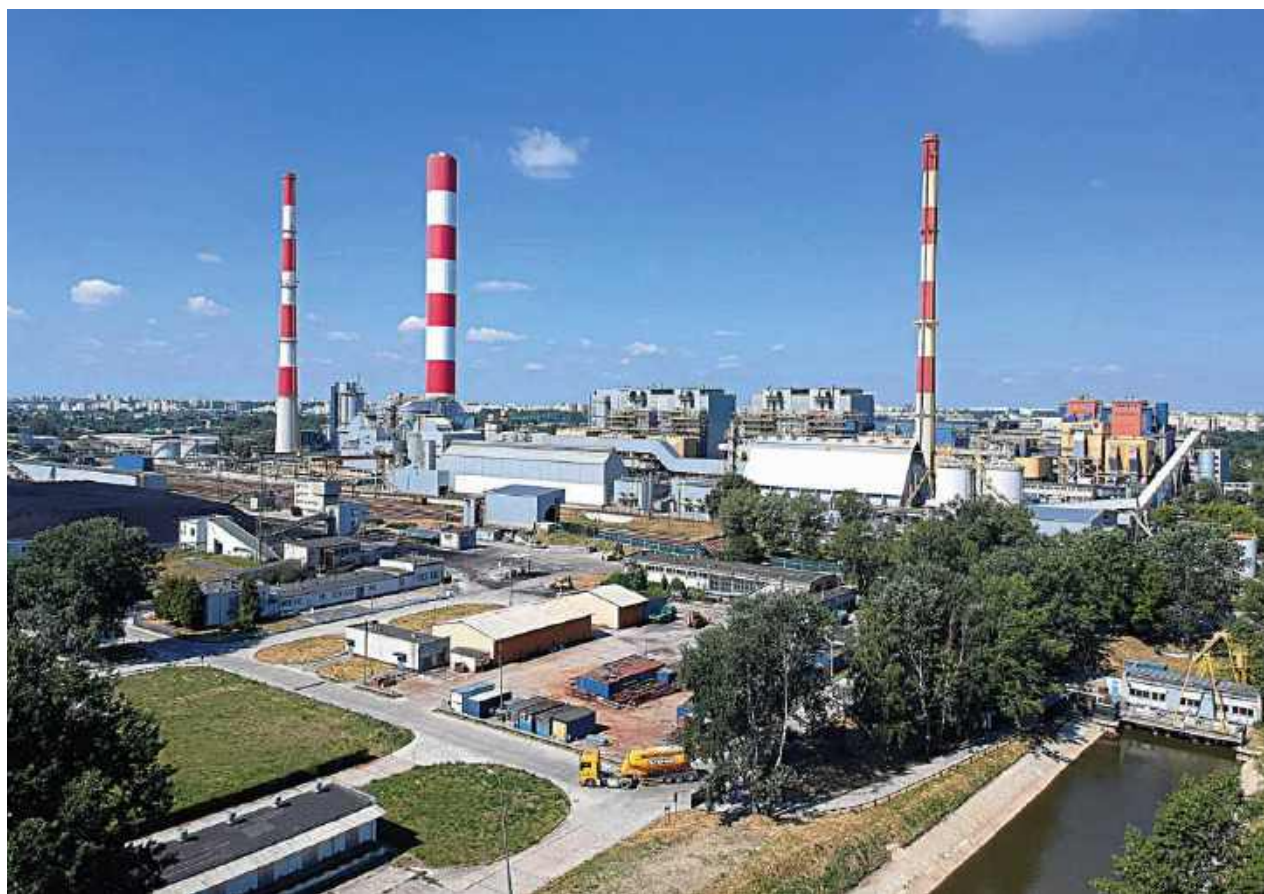
• Elektrociepłownia Siekierki. Bardzo ważna część infrastruktury krytycznej, niezbędnej do funkcjonowania miasta FOT. DARIUSZ BOROWICZ / AGENCJA WYBORCZA.PL
