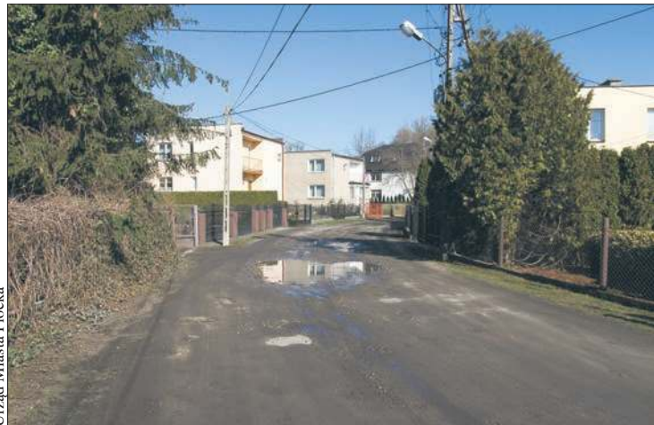
Trwają przygotowania do przebudowy ulicy Zakole
