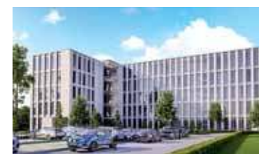
Realizacja Budowy Centrum Administracyjnego
