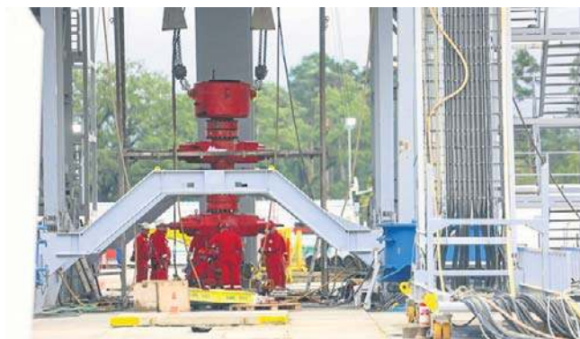
W wyrobiskach, tzw. kawernach, solnych w Kujawsko-Pomorskiem mogłyby powstać podziemne zbiorniki na gaz ziemny. Resort energii jednak tłumaczy, że taki zbiornik powstaje już w dolnośląskich Wierzchowicach (na zdjęciu)
