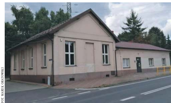
Budynek PMDK stoi pusty od ponad dwóch lat
