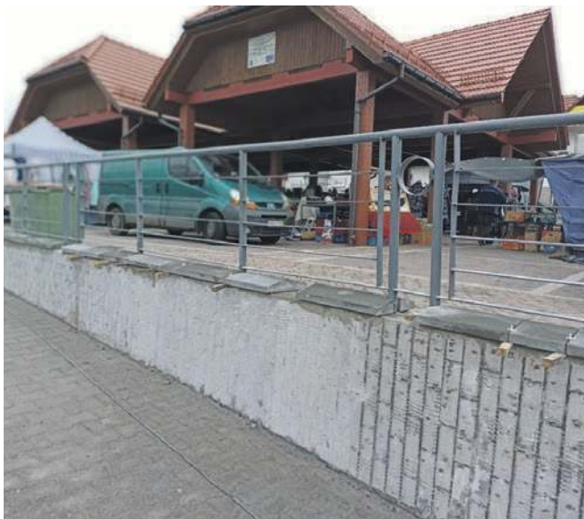
Wreszcie rozpoczął się remont brzydkiego murku miejskiego targowiska
