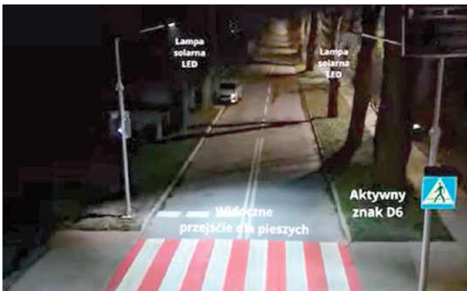
Przejście oświetlają lampy solarne
