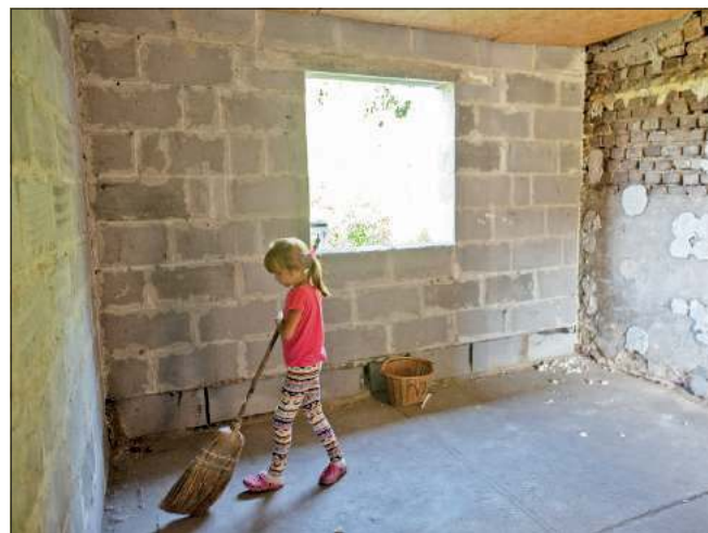
Tak wyglądały „pokoje” przed remontem
