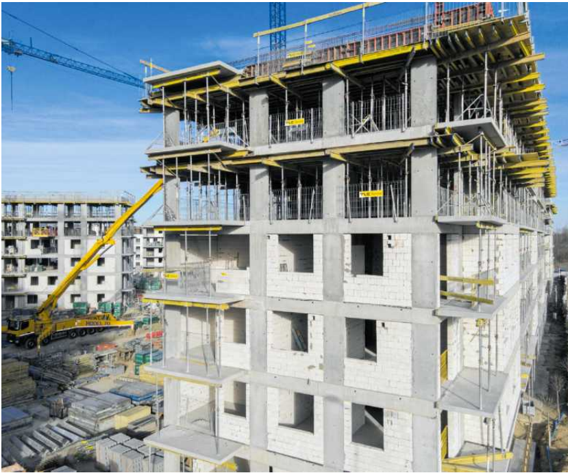
• Budowa osiedla w Warszawie, marzec 2023 r. FOT. ADAM STĘPIEŃ / AGENCJA WYBORCZA.PL
