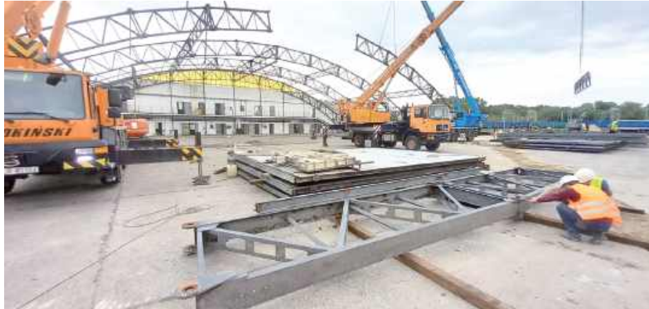
Trzy pojazdy i sześciu pracowników pracowało cztery tygodnie przy niezwykle dokładnym demontażu hangaru
