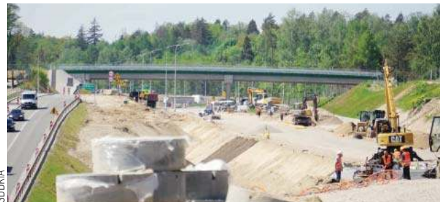
W Sorkwytach już widać nową drogę
