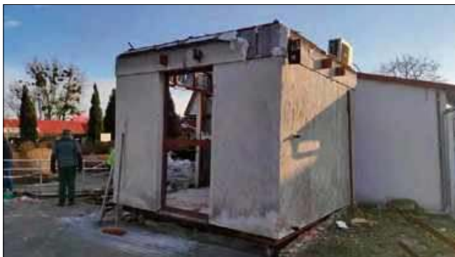
Kultowa budka totalizatora poszła do rozbiórki.
