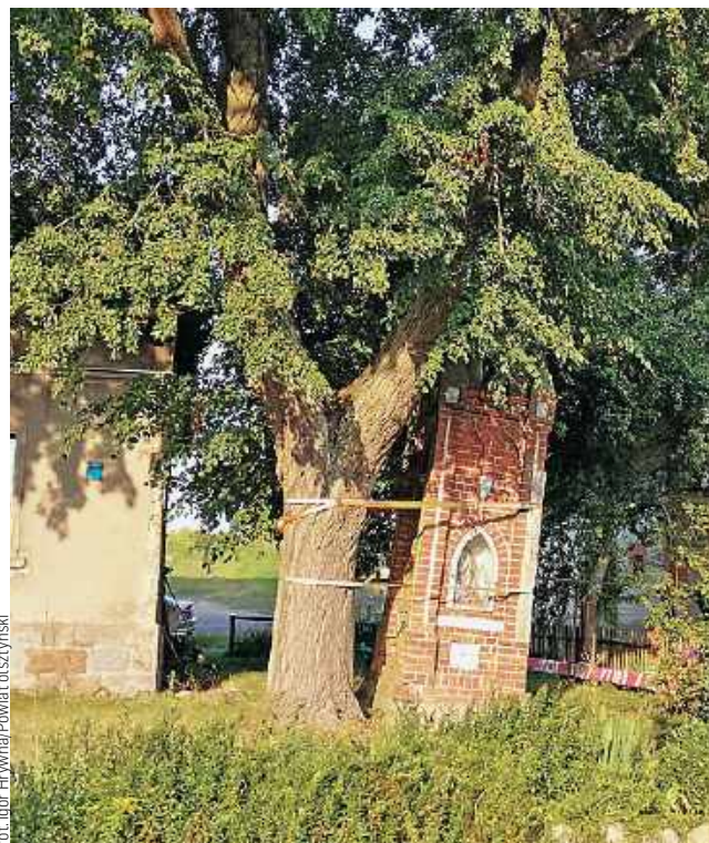
Kapliczka w Szczęsnem. Przed i po remoncie
