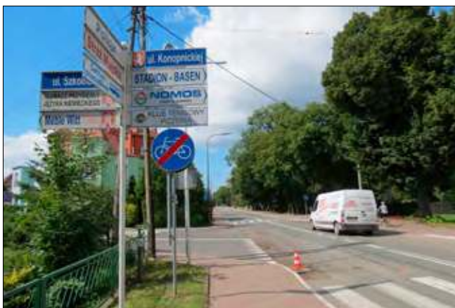
Tegoroczne roboty zaczną się od skrzyżowania z ulicą Górną, a za rok będą kontynuowane na odcinku wcześniejszym oraz późniejszym (od Szkolnej).
