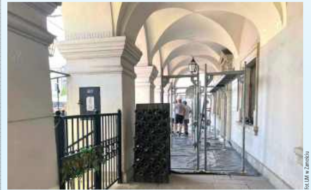
Prace w staromiejskich podcieniach w Zamościu potrwać maksymalnie 5 miesięcy
