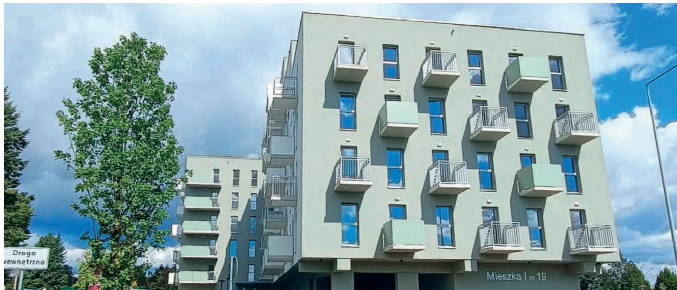
Nowy budynek SIM przy ulicy Mieszka I w Chrzanowie
