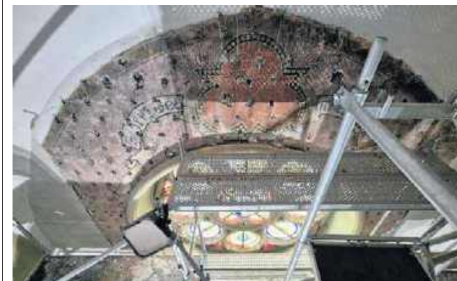
Zabytkowa dekoracja malarska została odkryta podczas prac remontowo-konserwatorskich
