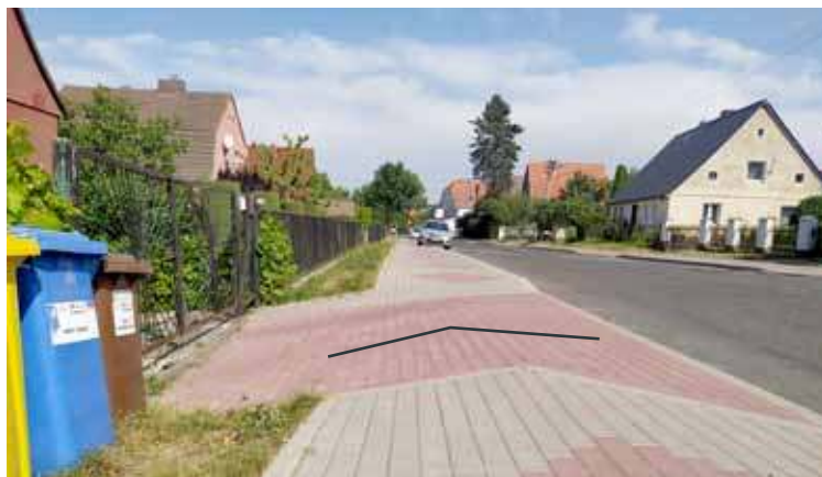
Wjazd na teren posesji jest obciążony sporym ryzykiem w postaci uszkodzenia auta
