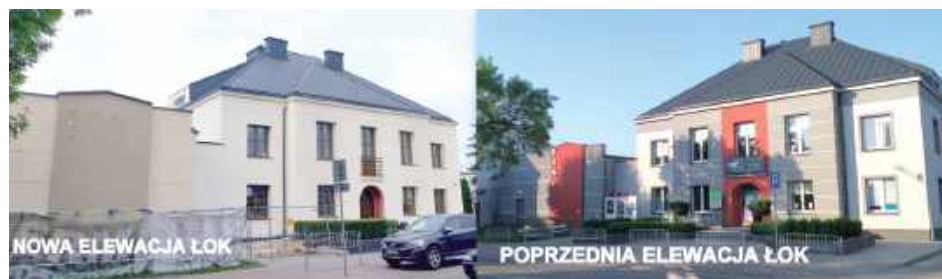
Nowa i „stara” elewacja Łukowskiego Ośrodka Kultury. Zmiana wywołała wiele komentarzy. Prace modernizacyjne w ŁOK-u nie są jeszcze zakończone, więc efekt końcowy przed nami, który - niewykluczone, że mile zaskoczy sceptycznych komentatorów zmiany elewacji
