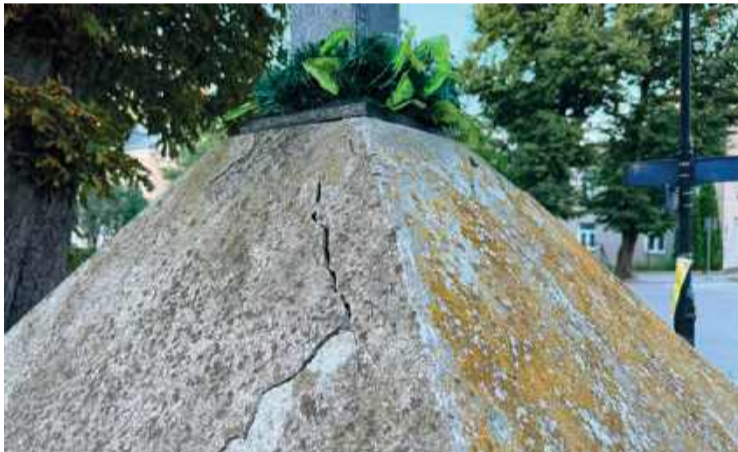
Pęknięcia od dołu do góry kamienia, w którym osadzony jest krzyż, bardzo niepokoją jego opiekunów
