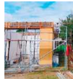
Prace w budynku OSP
