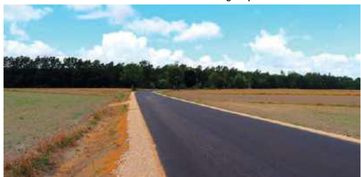
Droga Lipniki Stare-Przewodowo
