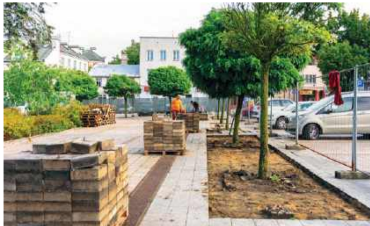
Trwa zdejmowanie nawierzchni z kostki. W jej miejscu pojawi się zieleni.
