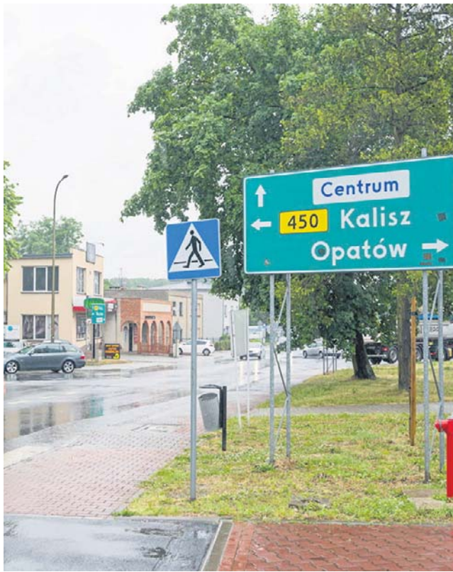
Droga wojewódzka nr 450 na odcinku Mirków - Wieruszów zostanie przebudowana
