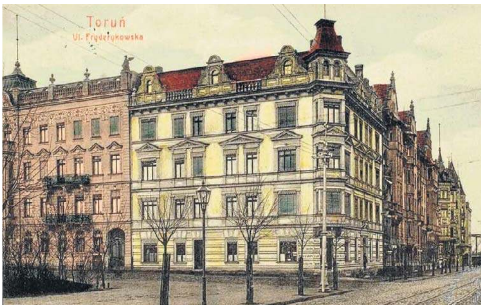
Kamienica na rogu Warszawskiej i Poniatowskiego. W listopadzie 1905 roku wybuchł pożar w znajdującej się tu restauracji
