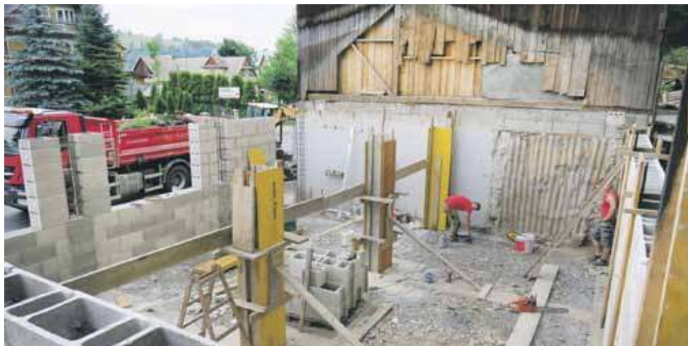
Tak wygląda "garaż" budowany w Białym Dunajcu tuż przy zakopiance.
