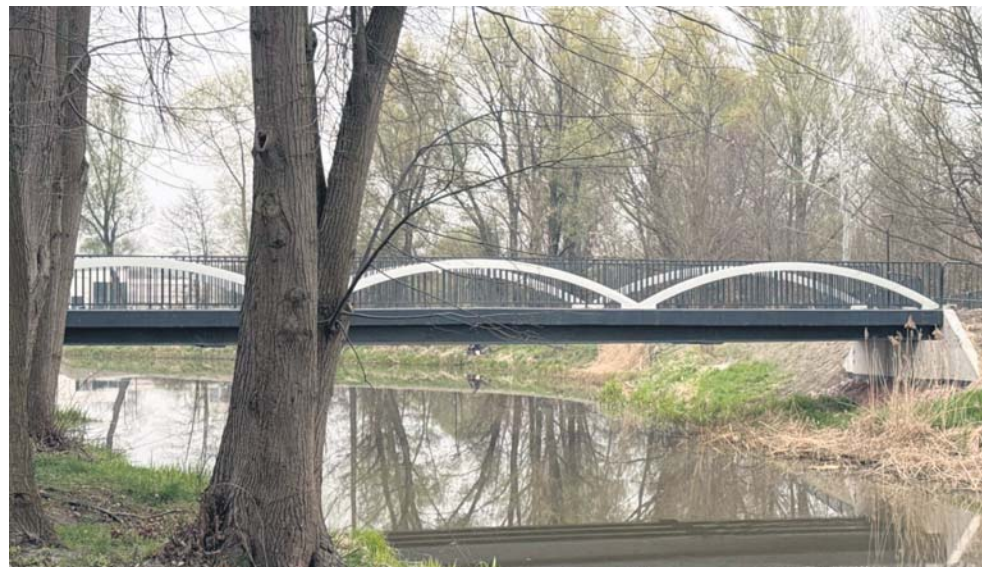
Nowy mostek i alejki spacerowe to kolejny etap zagospodarowania Terenów Nadpilicznych.
