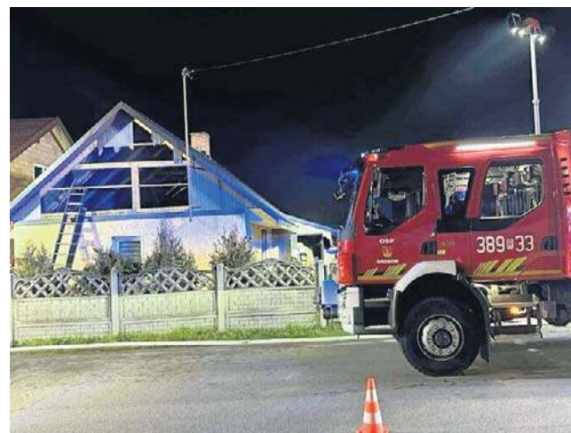
Dom został zniszczony w wyniku pożaru i zalania podczas akcji gaśniczej
