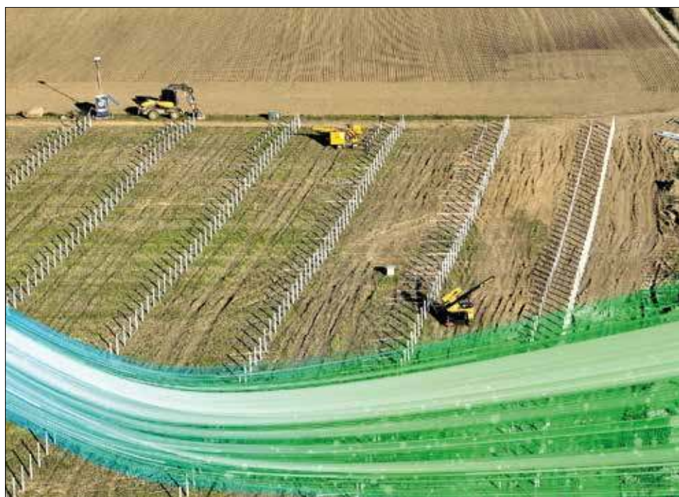
Budowa farmy fotowoltaicznej Dygowo I
