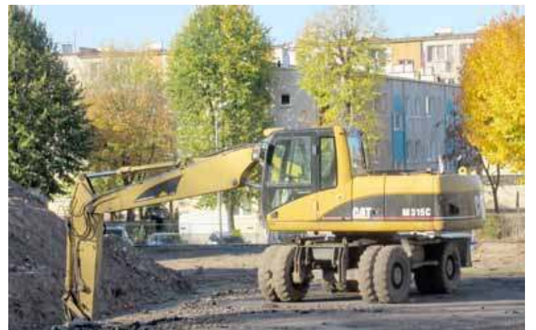
31 października 2018 na placu budowy jeszcze stała koparka. Potem nawet ona znikła
